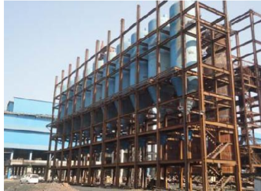
Blast Furnace - Latest Site Pictures
