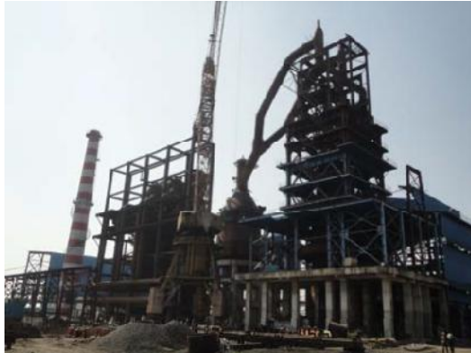
Blast Furnace - Latest Site Pictures
